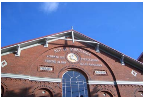
Alte Reithalle des Holsteiner Verbandes Elmshorn
